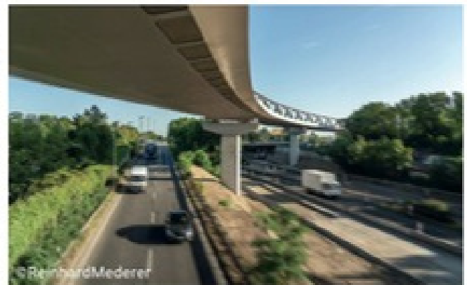
©Reinhard Mederer U81, 1. Bauabschnitt, Düsseldorf
